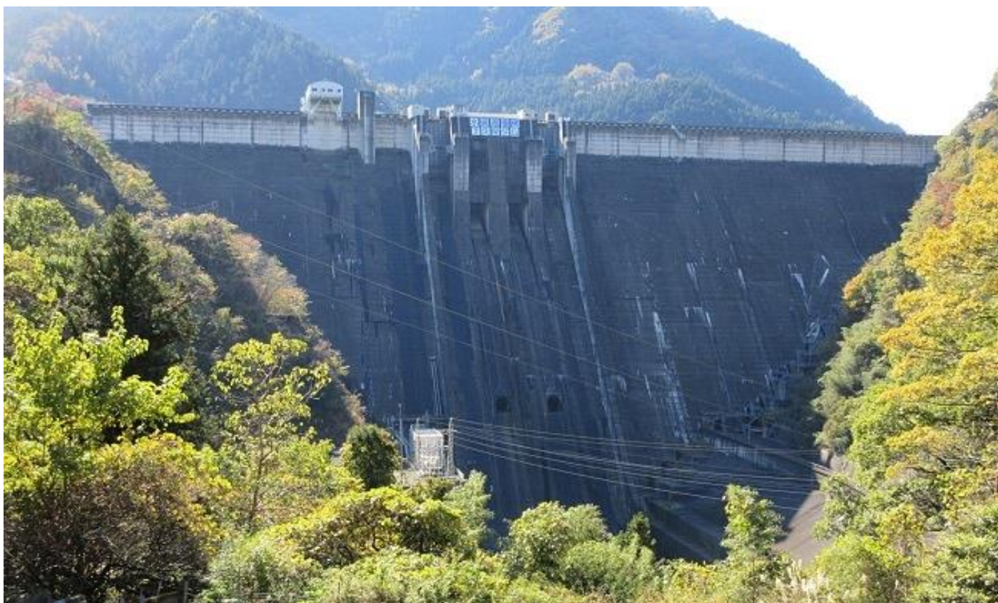
(ダム放出口正面)
