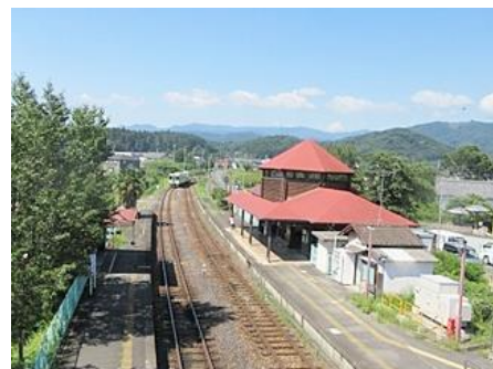
(跨線橋からの明覚駅全景)
