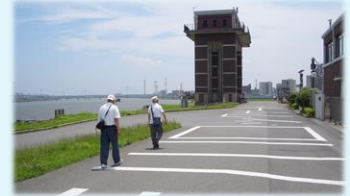
荒川ロックゲート
